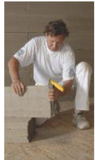
Die Bruchkante am besten mit dem Kantenhobel glätten
