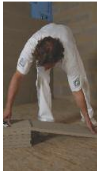
Die Platte lässt sich an der Schnittkante leicht brechen
